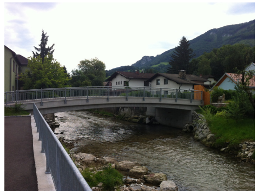
Brücke über die Kleine Ybbs in Ybbsitz, Objekt L6185.01
