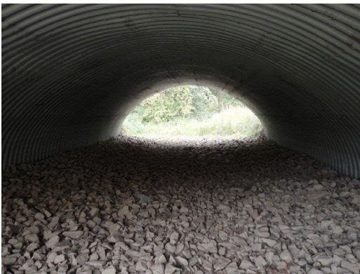
Brücke über die Kleine Laaben bei Ybbs, Objekt B25.05
