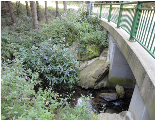
Brücke über den Glodenbach bei Kornberg, Objekt L7162.01
