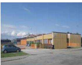
Brückenmeisterei St. Pölten
