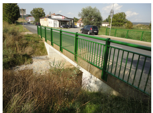
Brücke über den Breiteneicherbach bei Horn, Objekt B45.01
