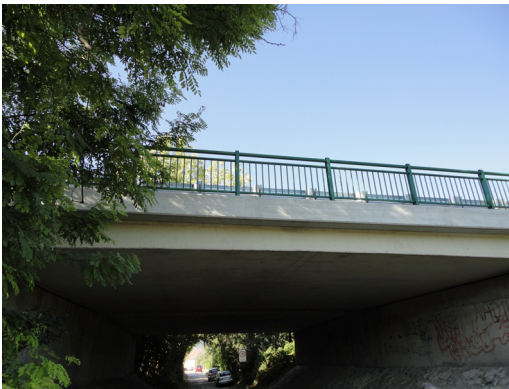
Brücke über einen Feldweg bei Baden, Objekt B210.07
