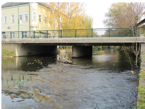
Brücke über den Leithakanal in Bruck an der Leitha, Objekt L2040.01
