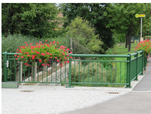
Brücke über den Windpassingergraben in Mittergrabern, Objekt L35.01
