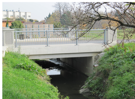
Brücke über den Petersbach in Vösendorf, Objekt L2007.02
