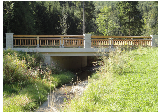
Brücke über den Klingenfurtherbach bei Walpersbach, Objekt L4096.03
