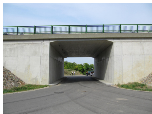
Brücke über einen Wirtschaftsweg bei Ravelsbach, Objekt B4.19b
