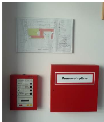
Feuerwehrbedienfeld mit Plankasten
