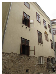
Krems Körnermarkt – Teil der Fassade im Zuge der Sanierung
