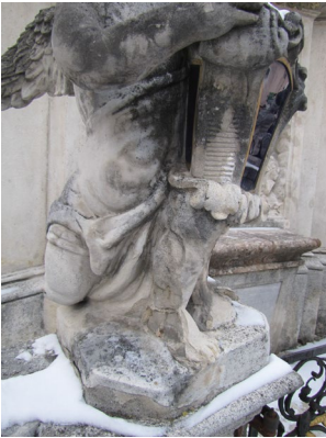
Dreifaltigkeitssäule Neunkirchen – Teilausschnitt vor der Restaurierung
