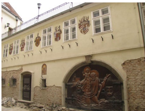
Krems Körnermarkt – Teil der Fassade im Zuge der Sanierung
